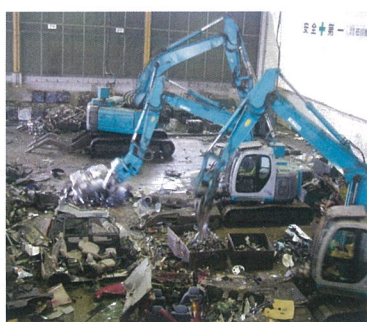
日本オートリサイクル(株)重機を使った解体作業
