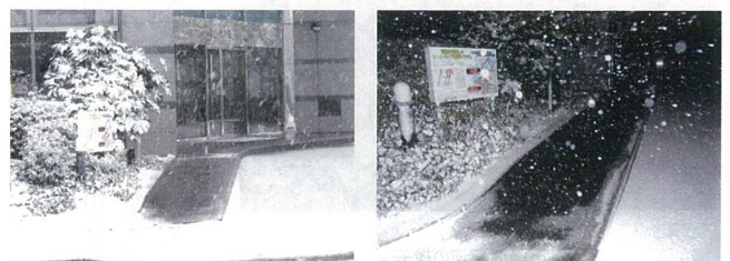
地熱ヒートパイプ融雪システム実験施設(興和本社玄関前)
