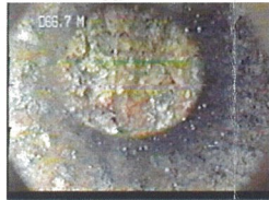
ケーシング管状況
